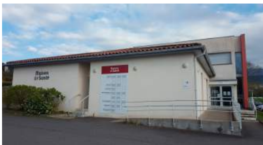
Maison de santé d'Aspet
